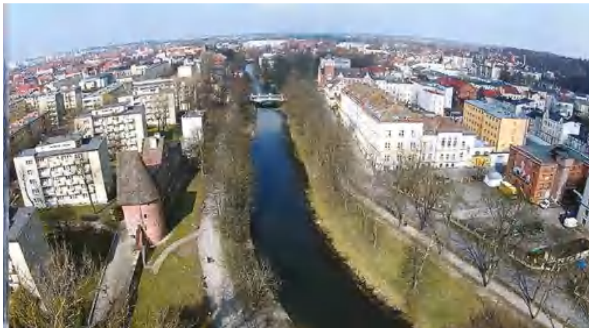
Fot. 11. Bulwary rzeki Słupi- stan istniejący
